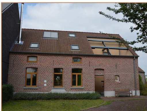
6 Verbouwing woning Kleempoelstraat 72, Zemst
