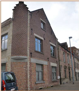
1 Verbouwing appartementen Cardijnstraat 11, Eppegem
