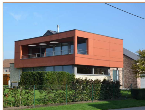
7 Verbouwing woning Kreupelstraat 121, Eppegem
