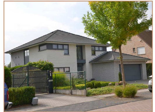
3 Nieuwbouw woningen Korporaal Trésigniesstraat 4-6, Eppegem
